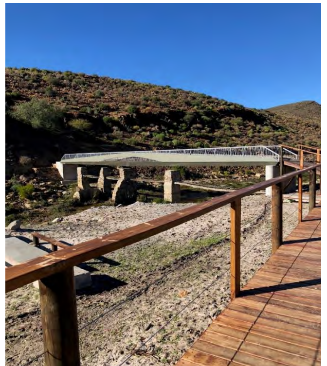
45 Ton Bridge Wupperthal
