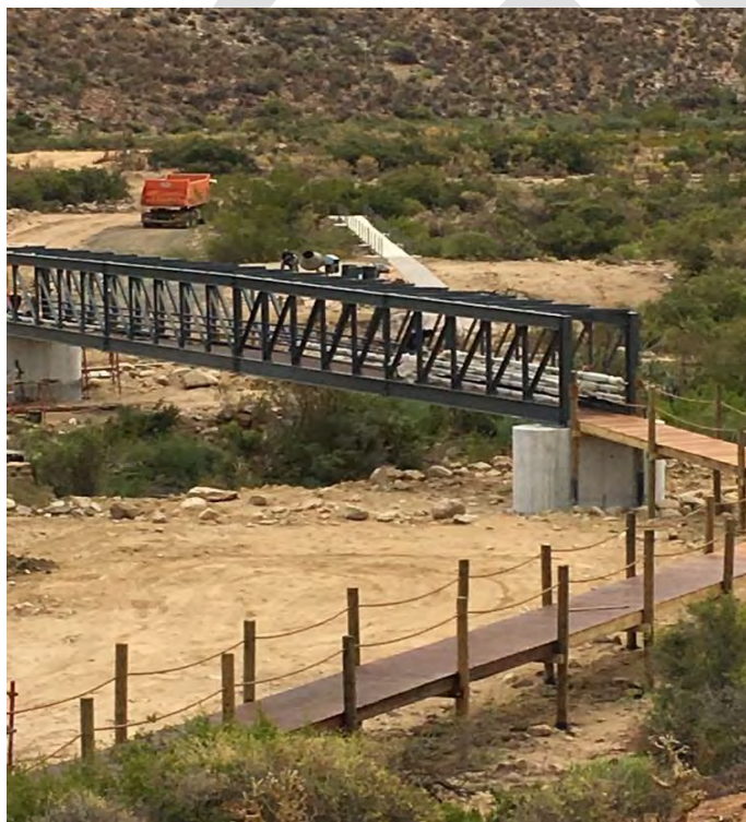
25 Ton Bridge Wupperthal
