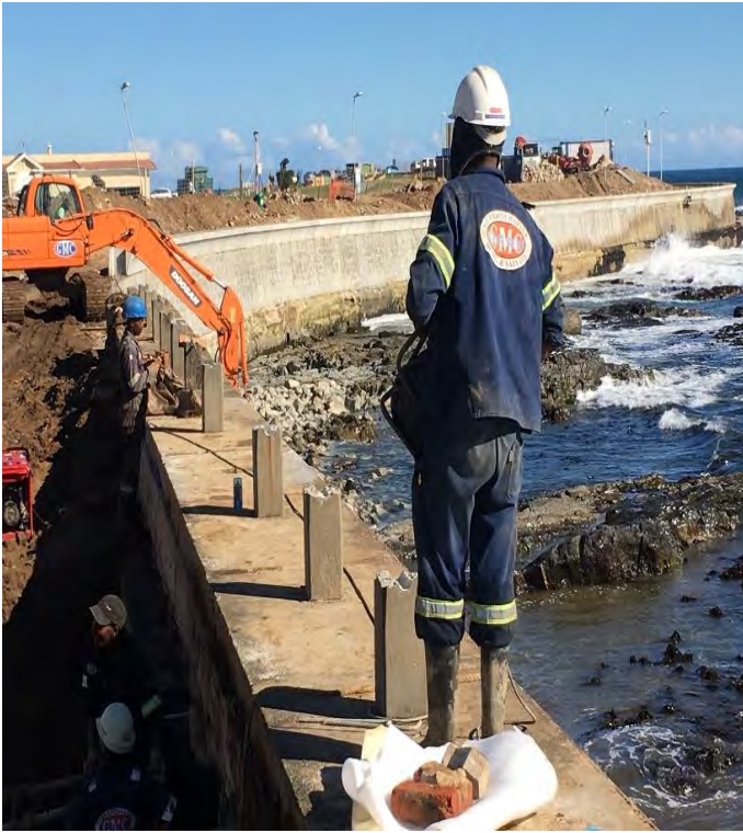
2km Sea Wall Mouille Point
